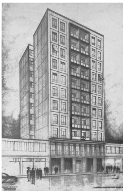
Figura 1 – Edifício ECB, 1948. Fonte: Olivo, 2014.
